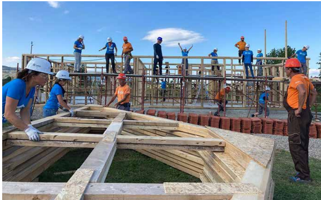
In Zusammenarbeit mit der NGO „Habitat for Humanity“ bauen Henkel-Teams Häuser für Familien in Not, hier z.B. in Rumänien.
